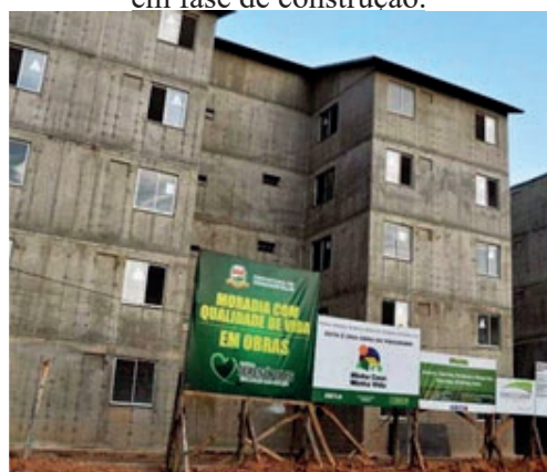
Figura 5 - Conjunto Habitacional Parque Ermitage em fase de construção.
