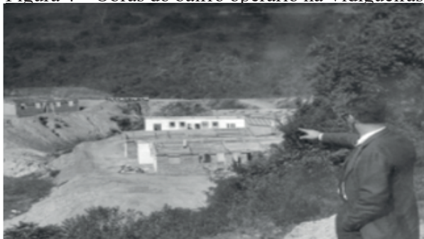
Figura 4 – Obras do bairro operário na Vidigueiras
