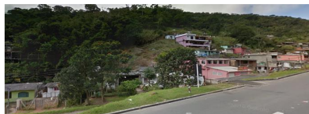
Figura 3 - Vista panorâmica das edificações.
