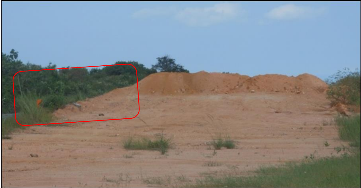
Figura 7: Foto de detalhe do material do sobreaterro, mostrando na lateral esquerda a pista da BR-493.
