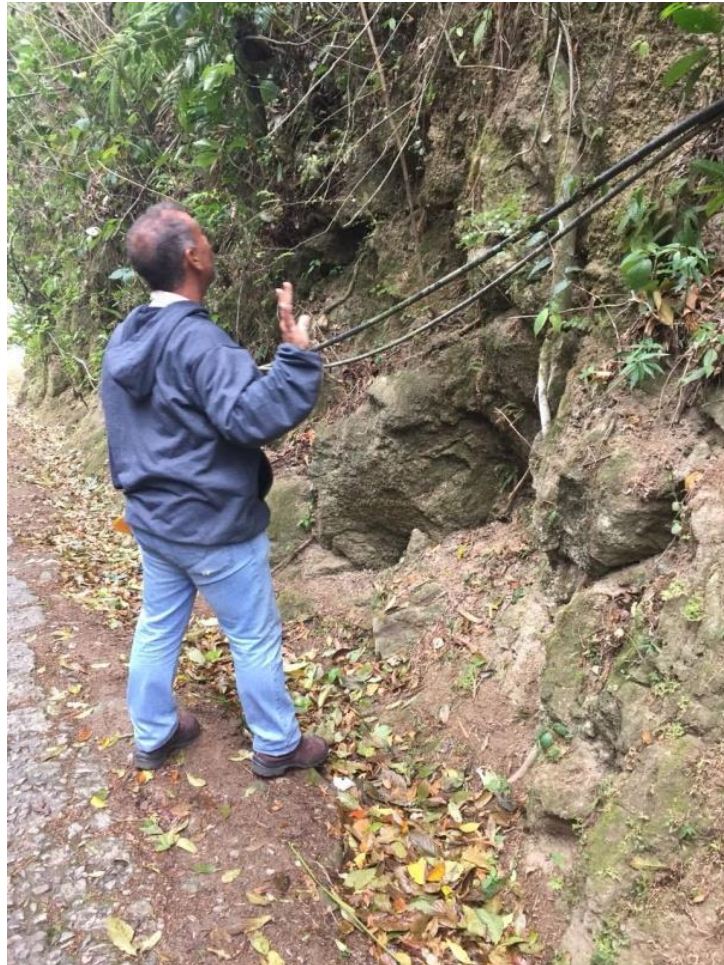
Figura 4: Detalhe de um dos taludes rochosos muito fraturados do Corte em caixão da antiga Estrada de Ferro Rio – Teresópolis.
