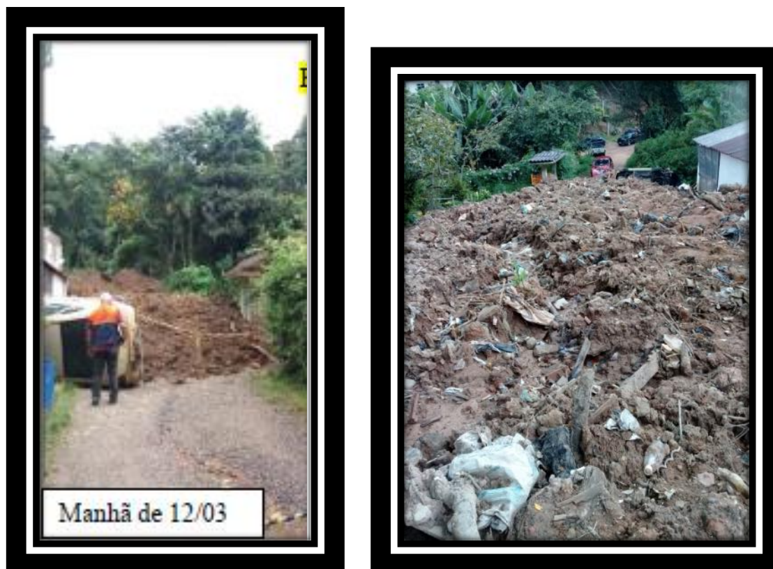
Figura 7: detalhe dos avanços do deslizamento em 12/03 e 20/03.
