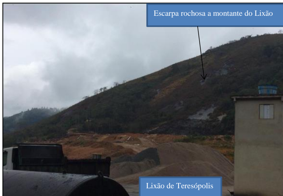
Figura 2. Vista para o talude do "Lixão" localizado no bairro Fischer.
