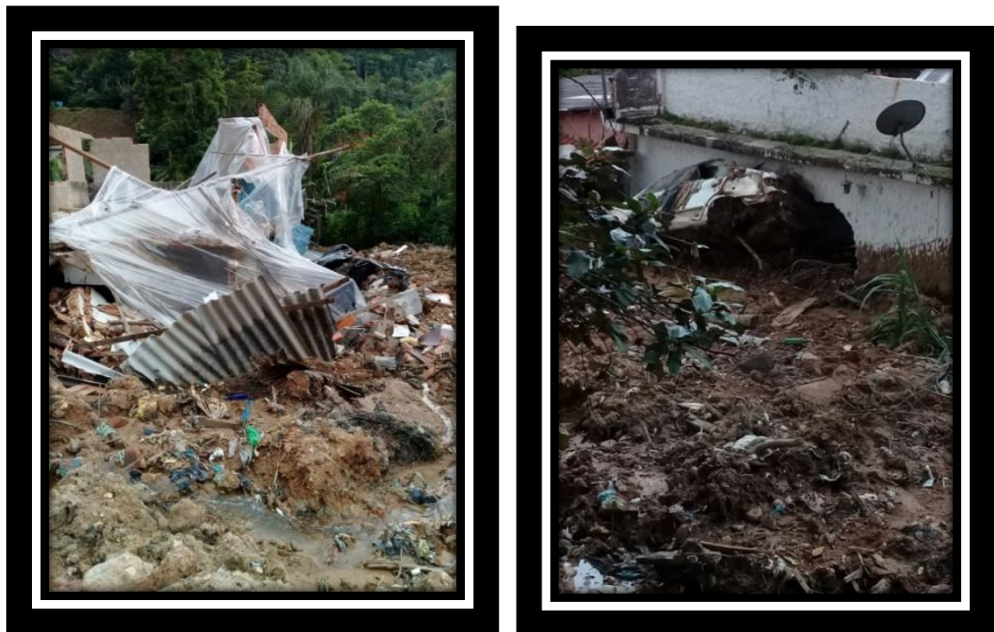
Figura 6: detalhe da destruição das casas situadas no eixo do escorregamento
