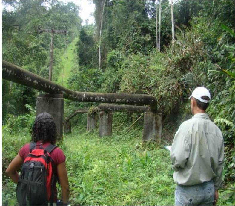
Figura 1: Vista do duto suspenso por estruturas de concreto. Fonte: Amaral et al, 2010.
