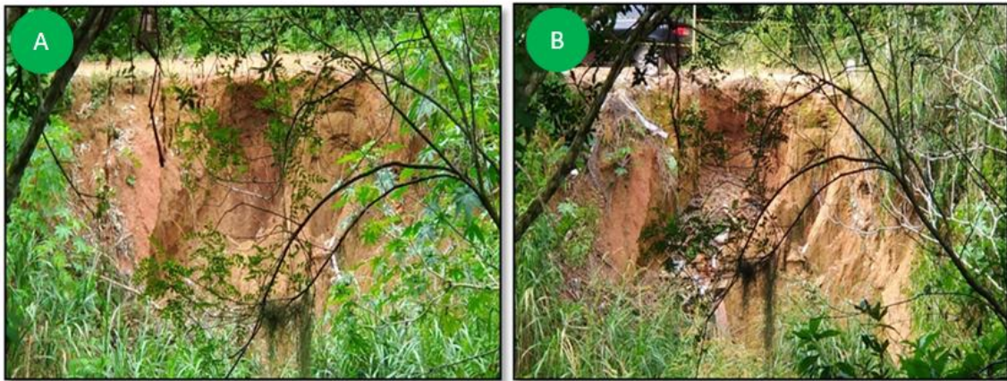
Figura 2 – Caracterização das modificações ocorridas pelo avanço progressivo de erosão entre 30/05/2017 (A) e da formação da voçoroca em 01/07/2017 (B)
