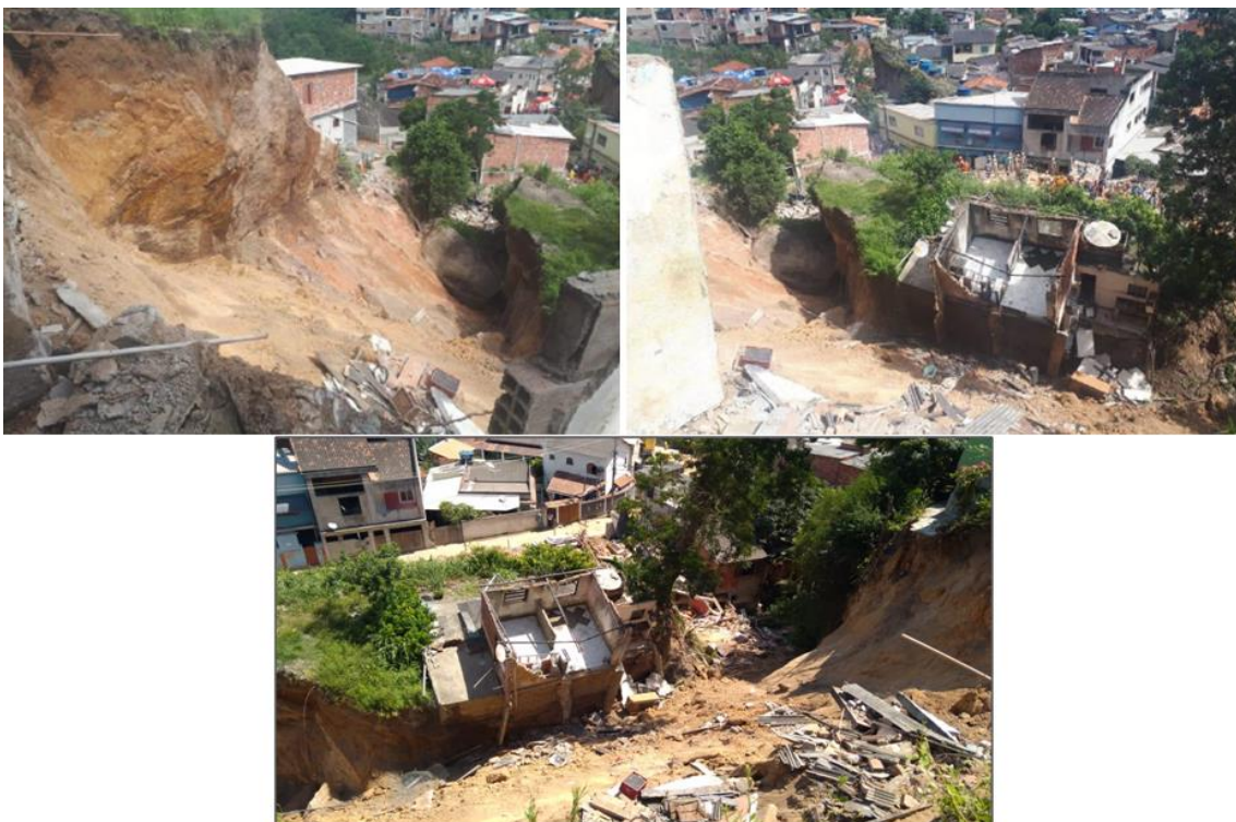
Figura 4. Vista da crista do escorregamento do Morro da Esperança.
