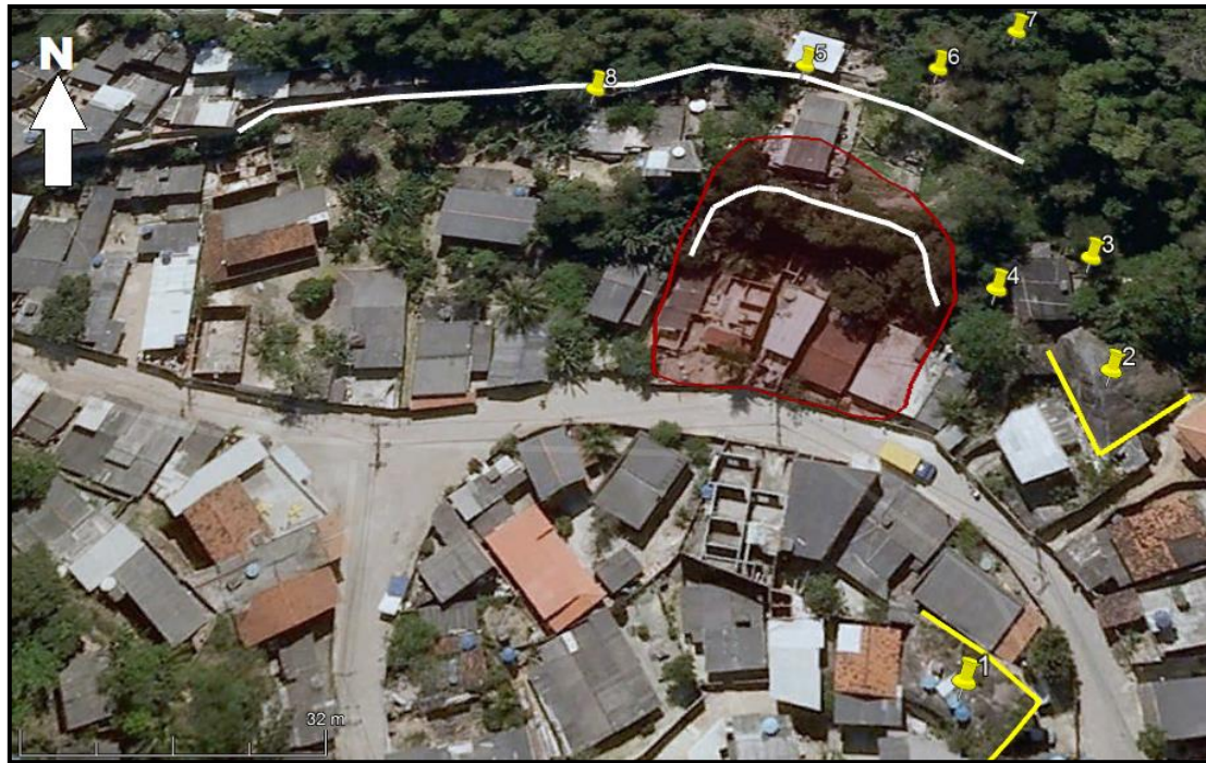
Figura 1. Pontos de mapeamento; em vermelho a área da cicatriz de deslizamento; em branco, os lineamentos das fraturas de alívio; em amarelo, os lineamentos das fraturas tectônicas.
