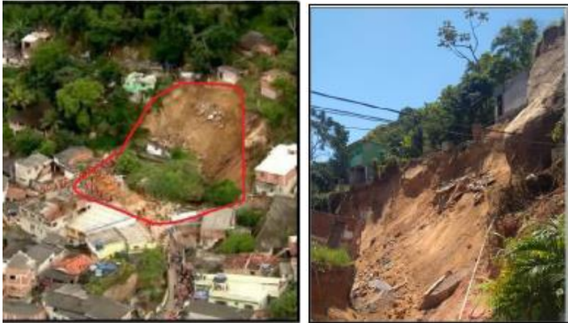
Figura 3: vista aérea oblíqua da cicatriz do escorregamento.
