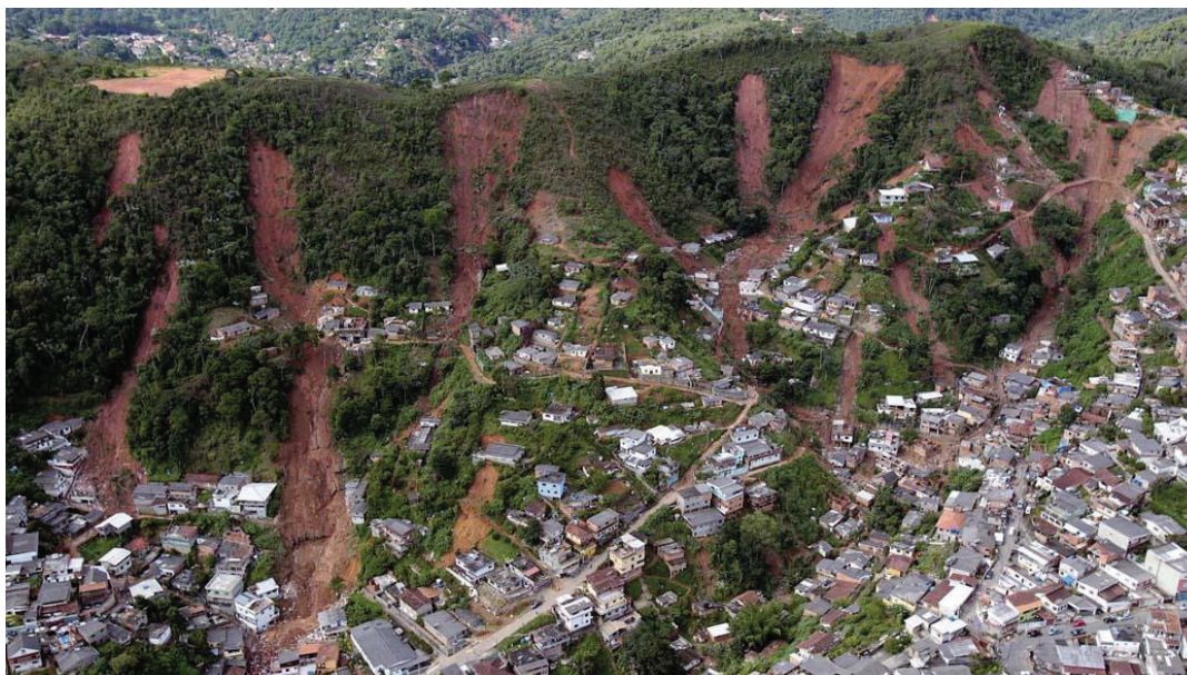
Figura 7: Vista Superior dos deslizamentos de terra em encosta no Loteamento Féo e Espanhol, em 2011
