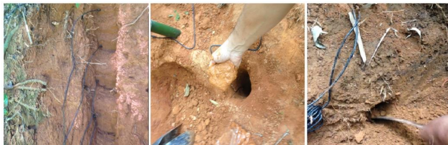
Figura 4: Diferentes técnicas de instalação; (a) cravação direta, (b) furo com lama e (c) cravação com auxílio do gabarito de aço.
