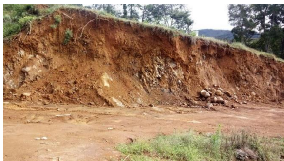
Figura 4: Vista frontal do talude exibindo desde rocha muito alterada até solo residual jovem.
