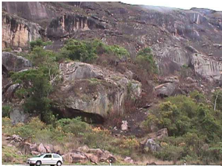
Figura 4: Vista frontal da zona de concentração de matacões rochosos in situ da BR-495. Neste ponto a rocha aflorante é o granito, uma rocha com alta resistência ao intemperismo. Por conta disto, o processo limitado aos planos de fratura gerando blocos individualizados.
