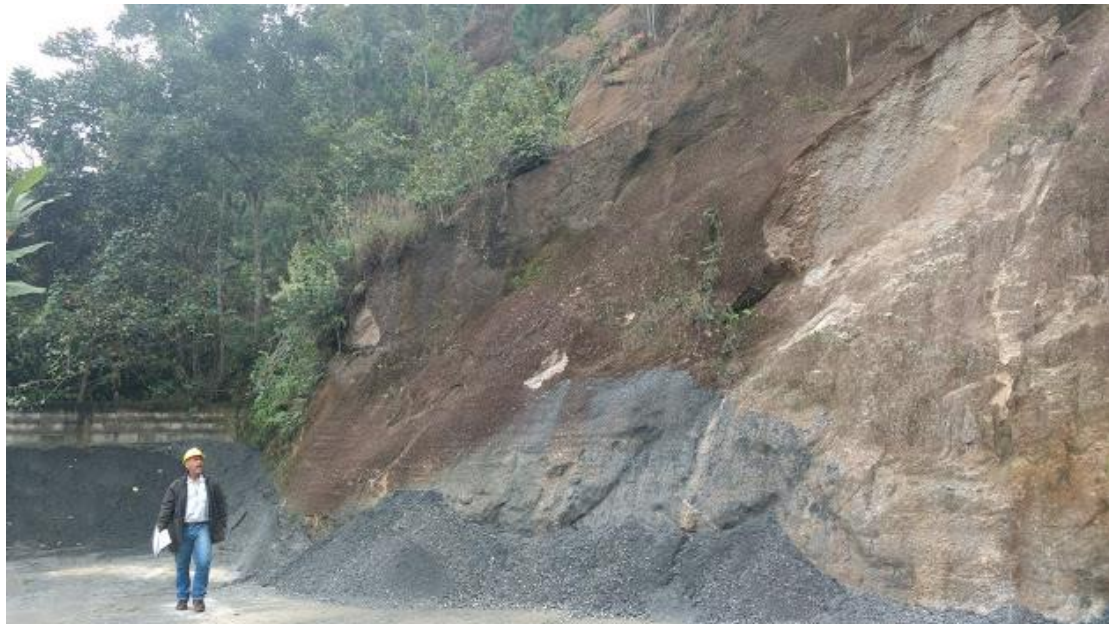
Figura 5: Vista lateral do ponto 04 situado em uma área de exploração de saibro (aterro) desativada. A escavação do talude expôs um perfil de intemperismo completo da rocha gnáissica, com variação dos horizontes desde rocha até solo residual, mas com camadas dispostas de forma irregular, em função do intemperismo diferencial.
