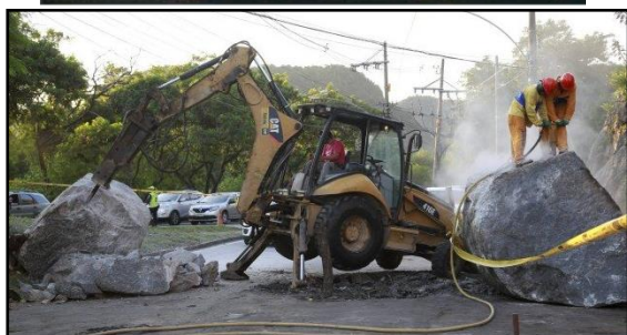
Figura 2: a) cicatriz do deslizamento; b) remoção dos dois maticões. (Foto: Marcos Ramos - Agência O Globo).
