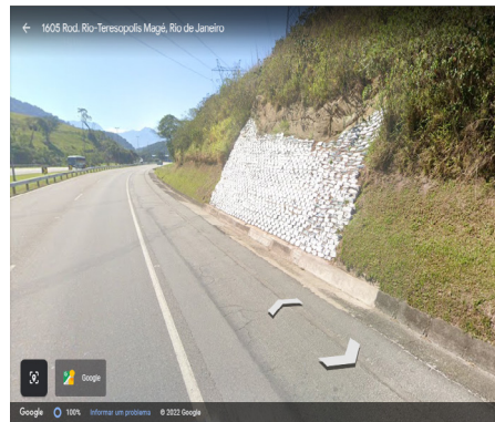
Figura 5 - Revestimento vegetal no corte do talude – km 113
