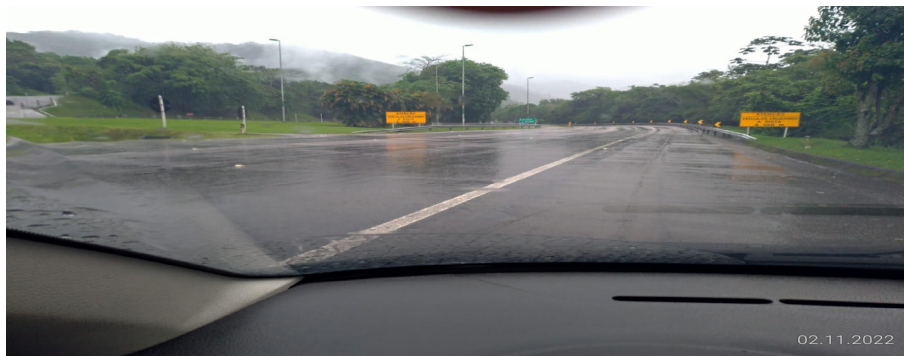
Figura 2 - Acúmulo de água no retorno – km 104
